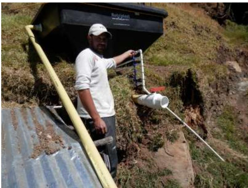
Figura 21 – Tolva de decantación. Fuente: Fundación Hidrosfera
