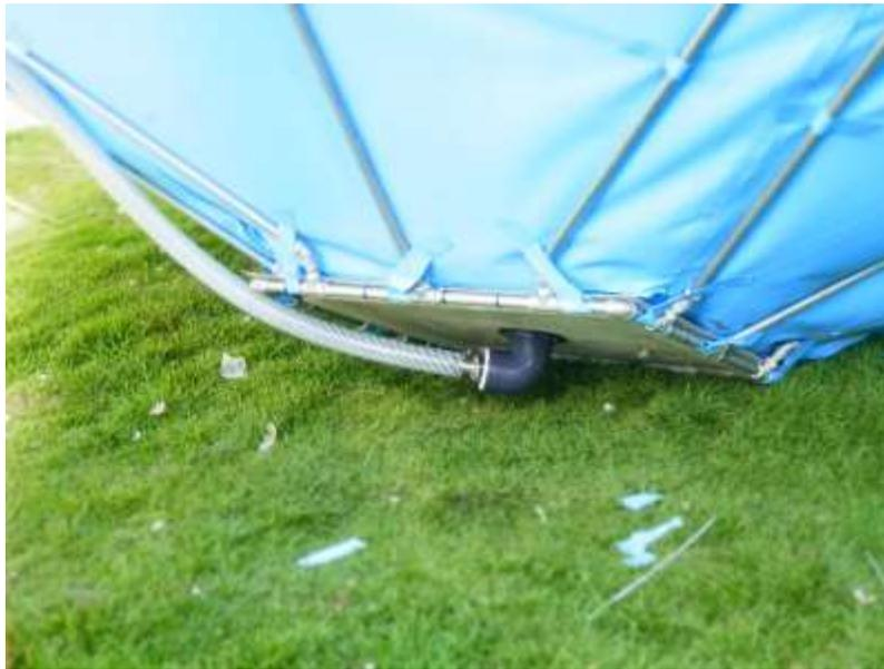
Figura 17 – Detalle de la instalación del sifón. Fuente: Fundación Hidrosfera
