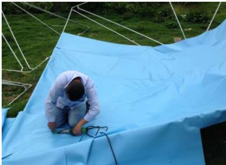
Figura 14 – Soldadura por calor de la lona de PVC. Fuente: Fundación Hidrosfera
