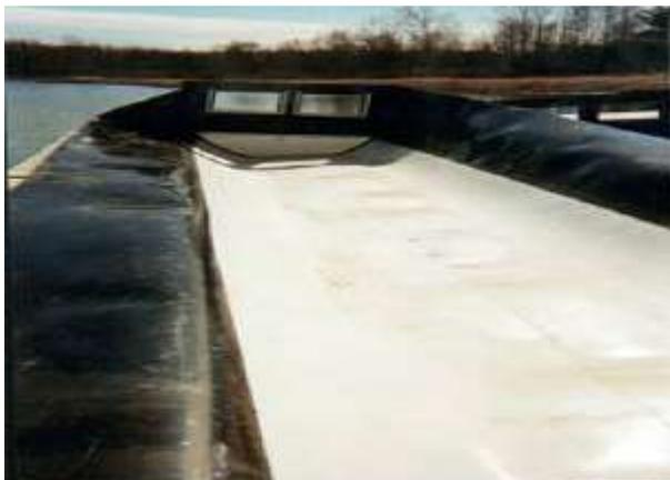
Figura 2 – Canal Flotante en construcción, donde se aprecia las paredes y pisos en geomembrana de PVC.
