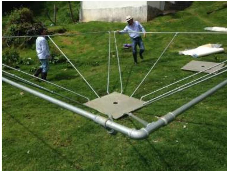
Figura 13 – Canastilla de soporte de tolvas. Fuente: Fundación Hidrosfera
