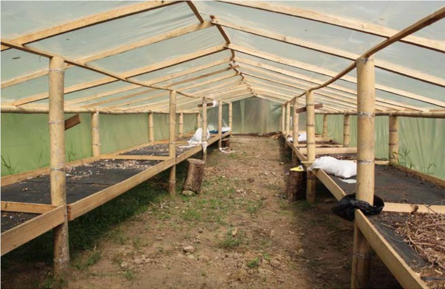
**Figura 1.** Secador solar construido con madera y plástico
